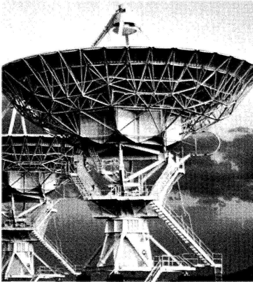
مقياس التداخل اللاسلكي البالغ الضخامة، وقد أقيم بالقرب من سكرور بنيومكسيكو بالولايات المتحدة. وهو من أقوى التلسكوبات اللاسلكية. ويتكون من ٢٧ طبقاً لاسلكياً قطر كل منها ٢٥ متراً.
