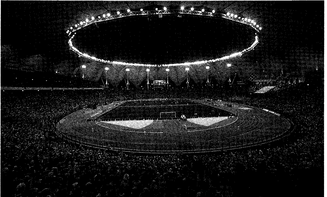
فتحة السقف الدائرية تساعد على تجديد الهواء، ومثبت عليها الكشافات الضوئية ووحدات الصوت.
