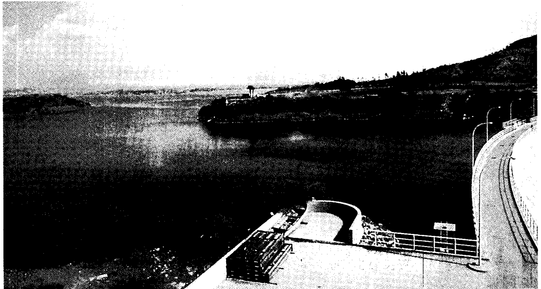
سد وادي جازان أهم مشروع حيوي في المنطقة. يبلغ ارتفاع السد ٦,٢٤ م فوق أعظم مستوى للأساس، وتتجمع عنده مياه خمسة أودية، بسعة تخزين ٧١ مليون م ٣ .
